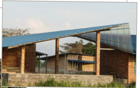
Schulgebäude mit den neuen Dächern
