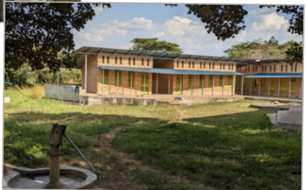
Schulgebäude mit den neuen Dächern und Brunnen
